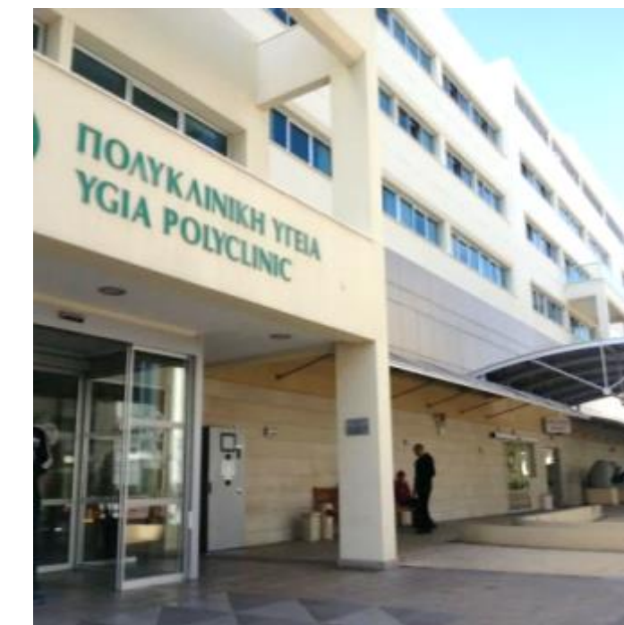
Частный Госпиталь в 9.9 км
